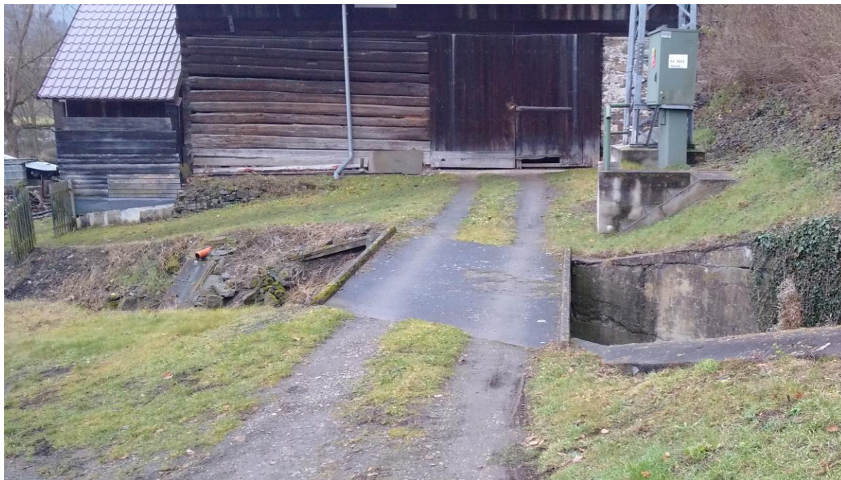
Pohled na most
