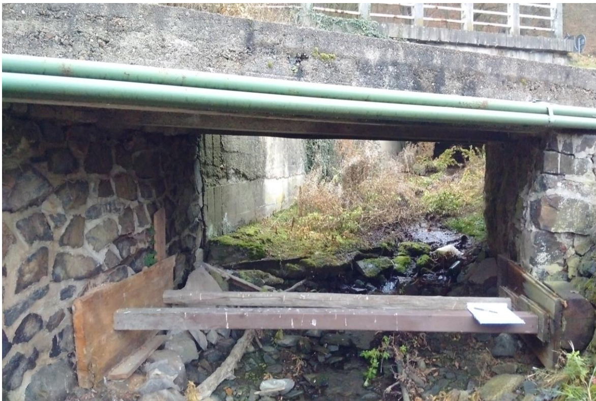
Detail pažení a koryta
