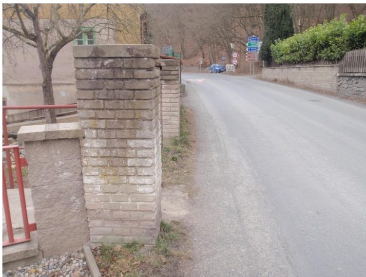
Foto 3: Zpevněná plocha podél oplocení – úsek B
