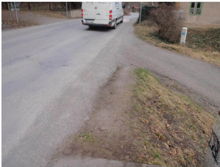
Foto 5: Oprava sjezdu mezi úsekem B a C
