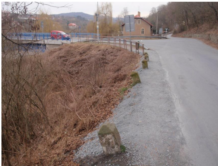
Foto 8: Nový chodník – úsek B
