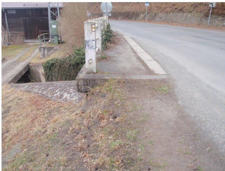
Foto 6: Nový chodník – úsek B (mírné zúžení profilu vozovky)
