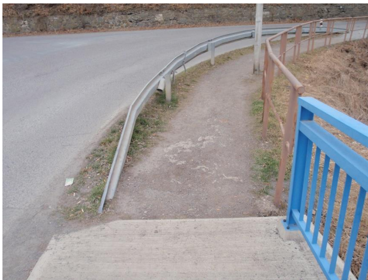
Foto 9: Napojení chodníku (úsek B) na stávající betonový chodník (součást mostu)
