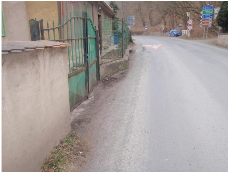
Foto 4: Zpevněná plocha podél oplocení – úsek B
