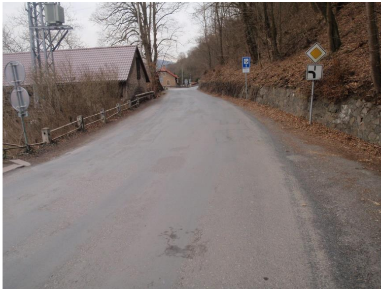
Foto 7: Nový chodník – úsek B
